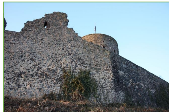
Befestigung und Bergfried der Hohenburg
