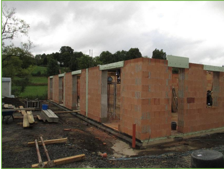
Noch im Rohbau
