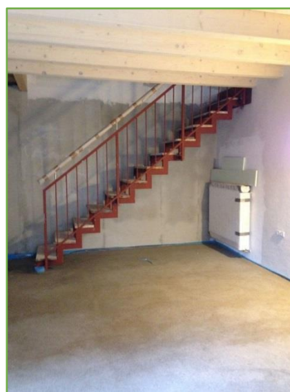
Innenausbau und Einbau der Treppe zum Obergeschoss © Sämtliche Fotografien: Christiana Schmidt
